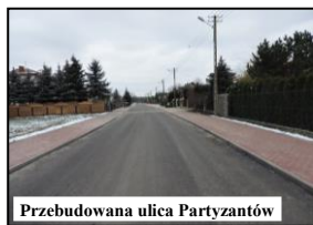
Przebudowana ulica Partyzantów
