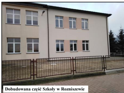
Dobudowana część Szkoły w Rozniszewie
